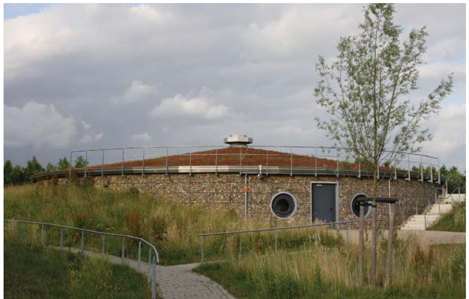
Der Wärme Speicher auf der Karlshöhe gehört E.ON
