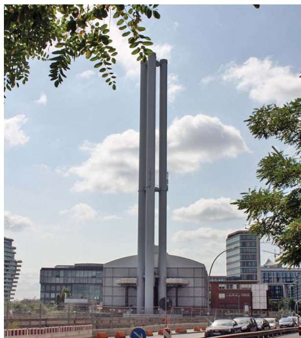
Kraftwerk Hafencity: 25,1% gehören jetzt der Stadt.
