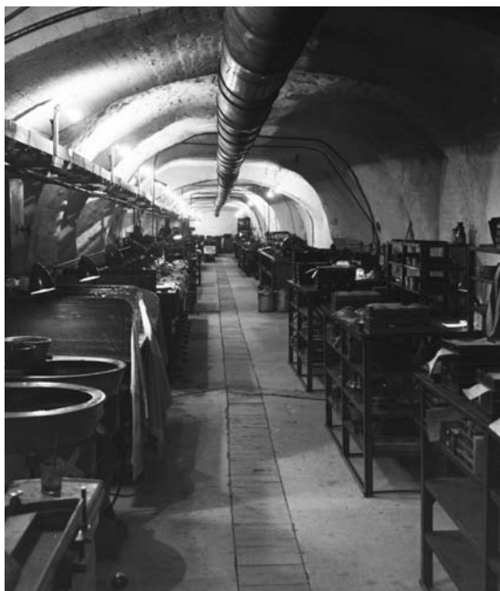
Baustelle des Rüstungsbetriebes „Schnäpl“ in Jena. (Quelle: Zeiss Archiv, BIII 14417)
