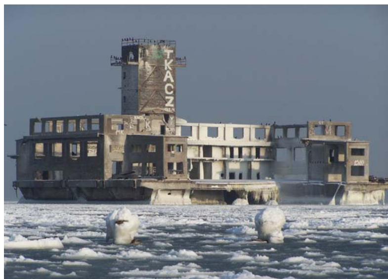
Der Torpedowaffenplatz Hexengrund war eine von 1942 bis 1945 betriebene Torpedotestanlage in der Danziger Bucht bei Gdynia (Gotenhafen). Hier wurden Torpedos vor dem Fronteinsatz geprüft. Das Gebäude hatte zwei Torpedo-Abschussschächte von 1,5 Meter Breite und 4 Meter Tiefe. Zwischen zwei kleineren Gebäuden in der Bucht war ein Netz gespannt, in dem die abgeschossenen Torpedos wieder eingefangen wurden. Wenige Kilometer entfernt, im Gotenhafener Stadtteil Adlershorst, hatte die PTR eine Niederlassung. (Quelle: Wikimedia)
