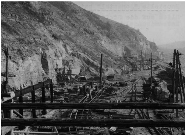
Baustelle im Jonastal bei Arnstadt für ein Führerhauptquartier. (Quelle: Gedenkstätte Buchenwald)
