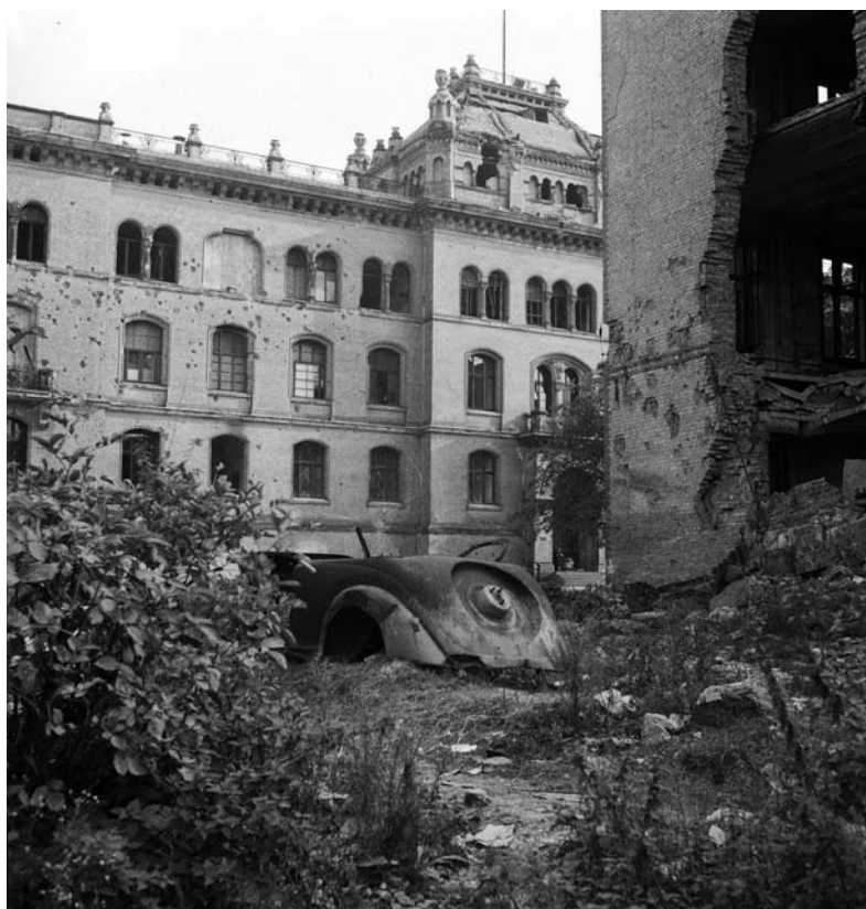
Der stark beschädigte Siemens-Bau auf dem PTR-Gelände in Charlottenburg 1945. (Quelle: PTB Archiv)
