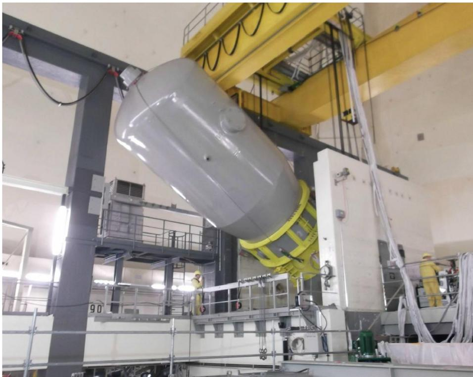
**Ausbau des Dampferzeugers im Kernkraftwerk Obrigheim**
