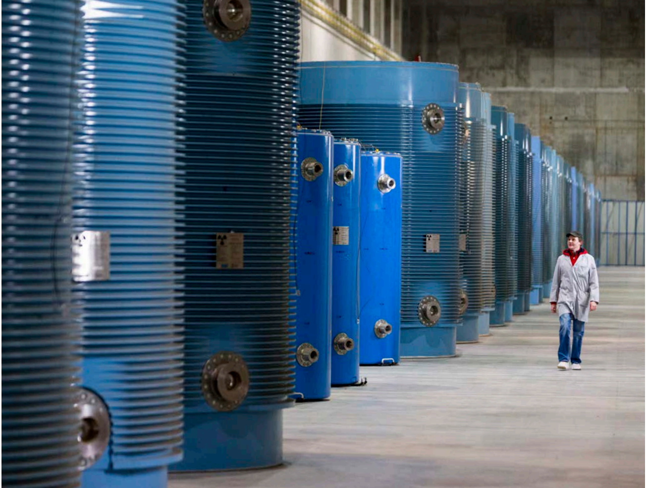
Halle 8 im Zwischenlager Nord
