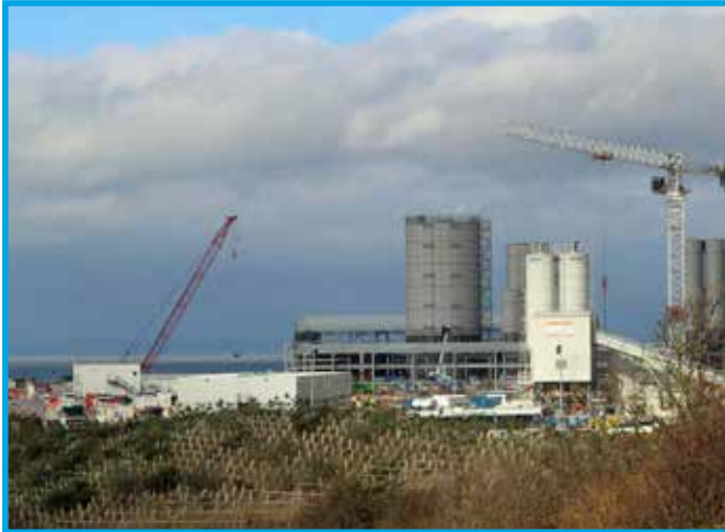
BAUSTELLE DES UMSTRITTENEN AKW „HINKLEY POINT C“
