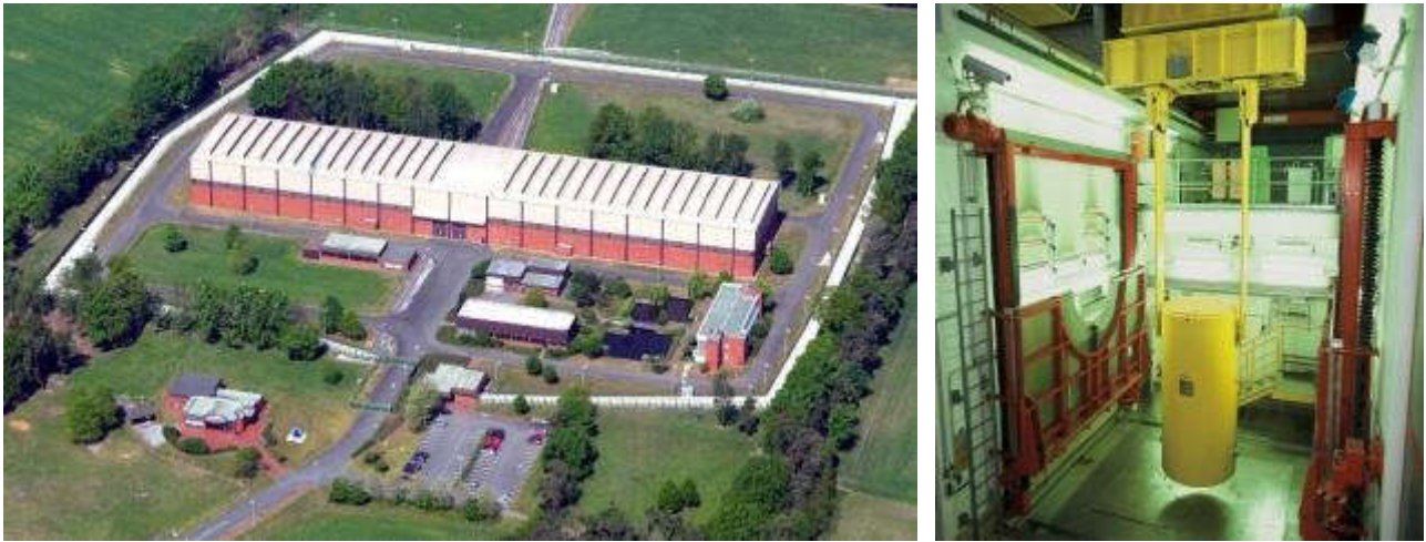
Abbildung G-2: Zwischenlager Ahaus (Bildrechte: BGZ)
