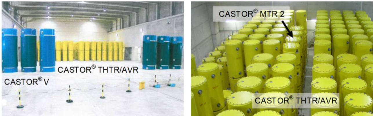
Abbildung D-5: Brennelemente-Zwischenlager Ahaus (links: CASTOR® V und CASTOR® THTR/AVR, rechts: CASTOR® MTR 2 zwischen CASTOR® THTR/AVR) (Bildrechte: BGZ)
