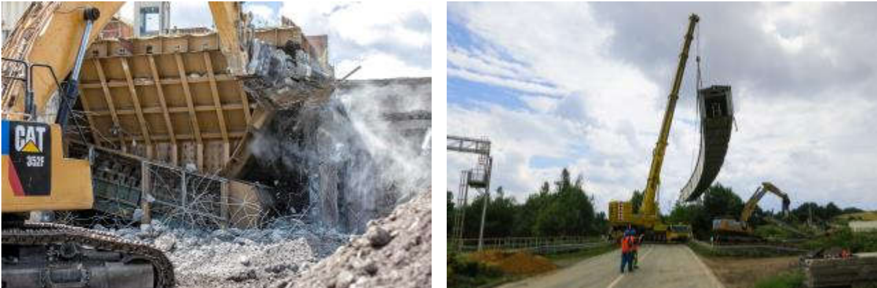
Abb. 2: Demontage und Abbruch des Pipe Conveyor am Standort Crossen (2017/2018, Bildrechte: Archive WISMUT)
