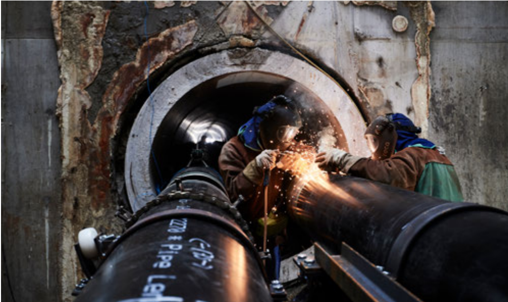
MEDIENTUNNEL UNTERHALB DER A7 – ein Vorzeigeprojekt beim Autobahn- deckel in Altona zur Minimierung von Bauzeit und -kosten. HAMBURG WASSER koordiniert den Bau von Versorgungs- trassen unterhalb der Autobahn für Trinkwasser, Abwasser, Strom, Gas und Telekommunikation gemeinsam mit acht Partnern aus der privaten und kommu- nalen Versorgungswirtschaft.
