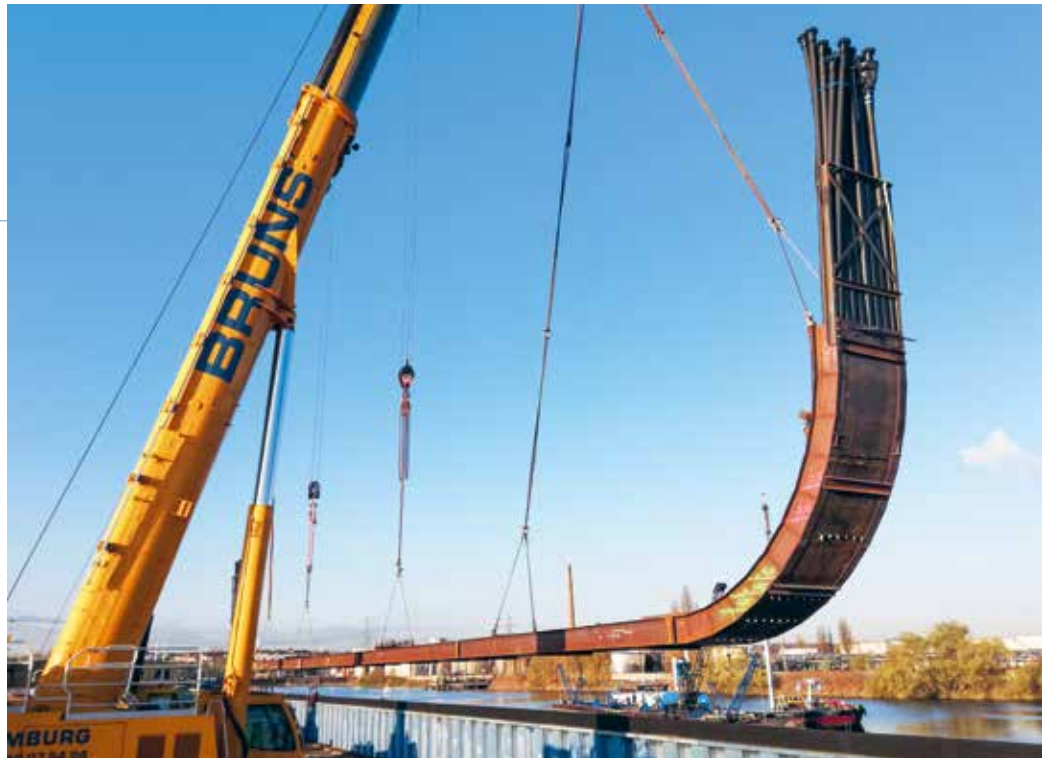
Sanierung Kabeldüker Lotsekanal / Rückbau 110-kV- Freileitung 2020/21
