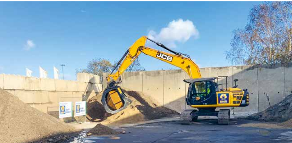
Siebvorgang beim Bodenaushub
